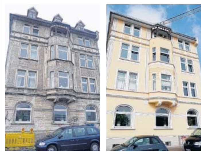
Das Programm wirkt: Eine Bielefelder Fassade vorher. ... und nach der Sanierung der Fassade.
