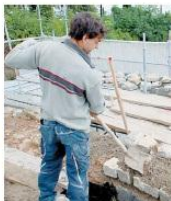
Neue Kante: Die Sanierung des Schuster Rondells, hier mit Falko Krah von der Firma SIR aus Hitzler (Leipzig), ist weit fortgeschritten. Das Marienrondell im Hintergrund ist noch von Efeu bewachsen. Hier ist die Sanierung im nächsten Jahr geplant.
